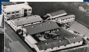
鈴鹿工場竣工（1965年）
