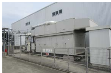
Gas cogeneration system (Kanto Plant)
