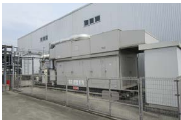
Gas cogeneration system (Kanto Plant)
