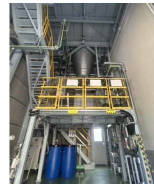
新乾燥棟内部
