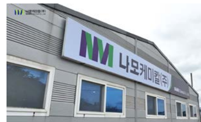
NAMO Chemicalのパイロットプラント完成 (2025年10月)
