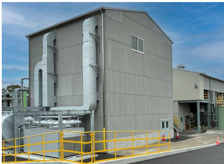
粉体棟(新建屋)
